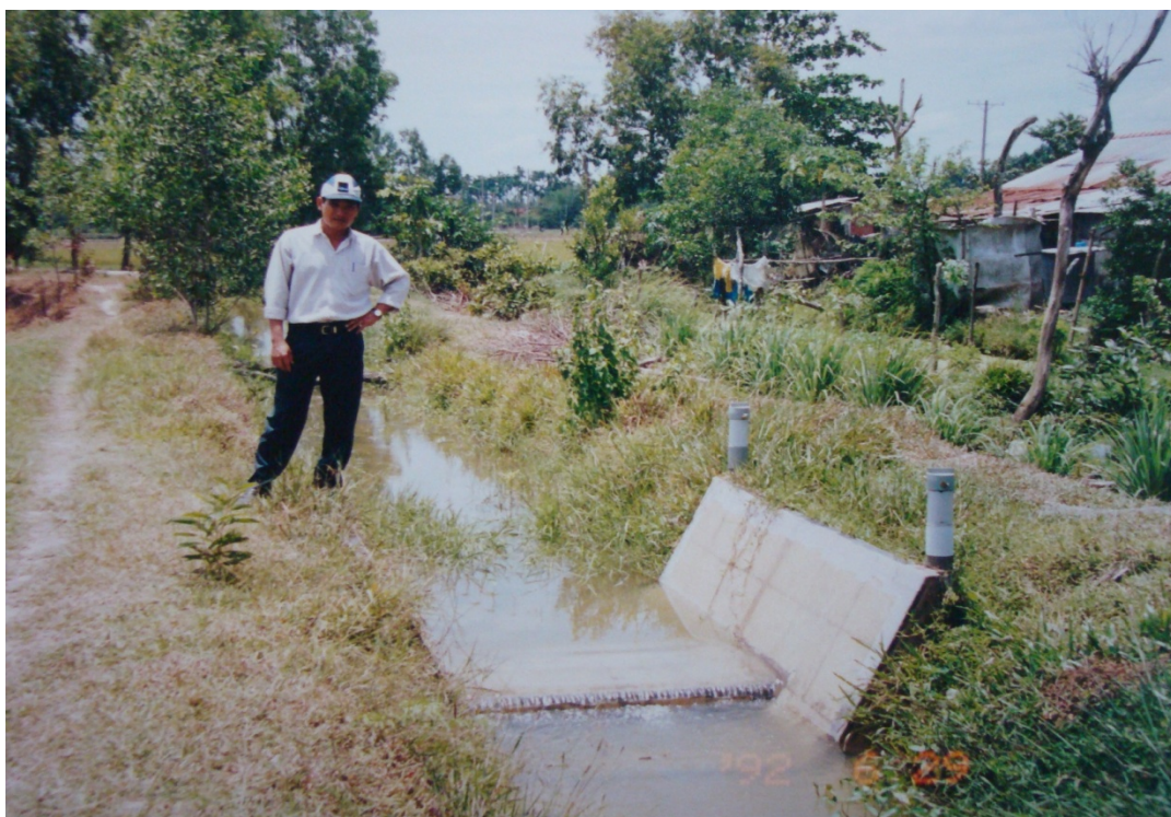
Máng đo nước tiêu tự động T43-1, hệ thống kênh Đông Củ Chi.
