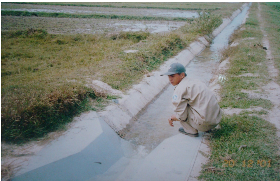
Máng đo lưu lượng tưới với quan trắc tự động mực nước - Hệ thống kênh Đông Củ Chi
